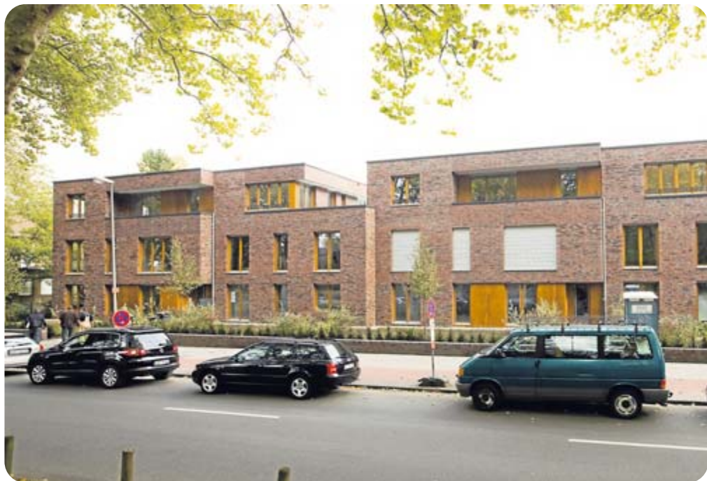
Der exklusive Neubau in beliebter Lage von Münster: Piusallee 84 und 86. Moderne Architektur verbindet sich mit Materialien wie Holz handgeformten Ringofenklinkern. Foto MünsterView/Heiner Witte
